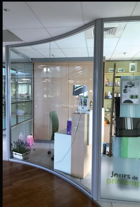
*CLIPS est un système qui permet aussi de travailler aisément des cloisons courbes. Installation pour EM2C*
